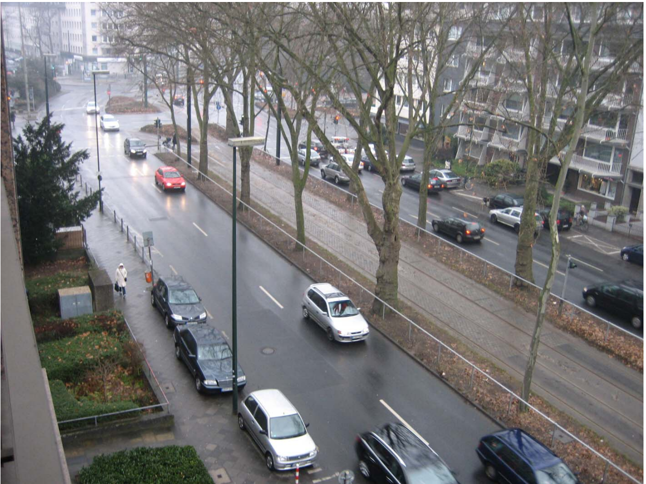
Ansicht Straße von Oben
